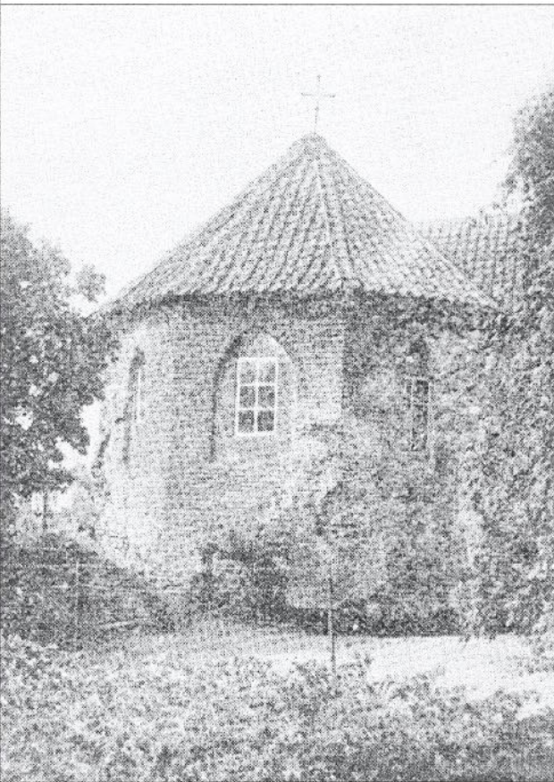
een katholiek priester op het kasteel. Het oude kerkje staat er nog. Ook de altaarsteen is nog aanwezig.
