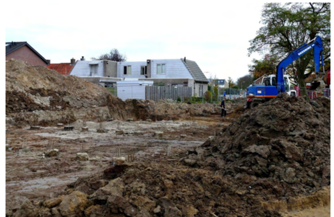
De voorbereiding en boorfundatie's voor de nieuwbouw.
