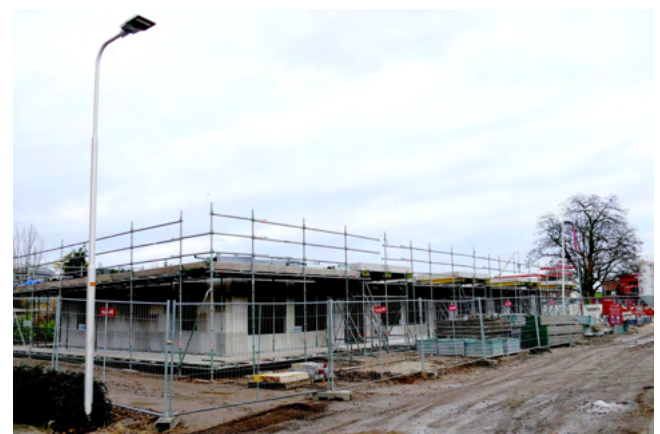
De eerste bouwelementen voor nieuwbouw zijn geplaatst.
