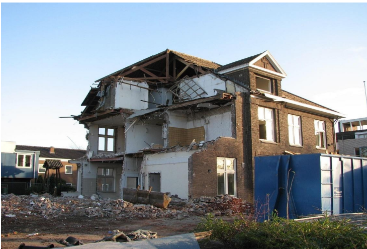
Gedeeltelijke sloop van het Zorgcentrum St. Jozef.
