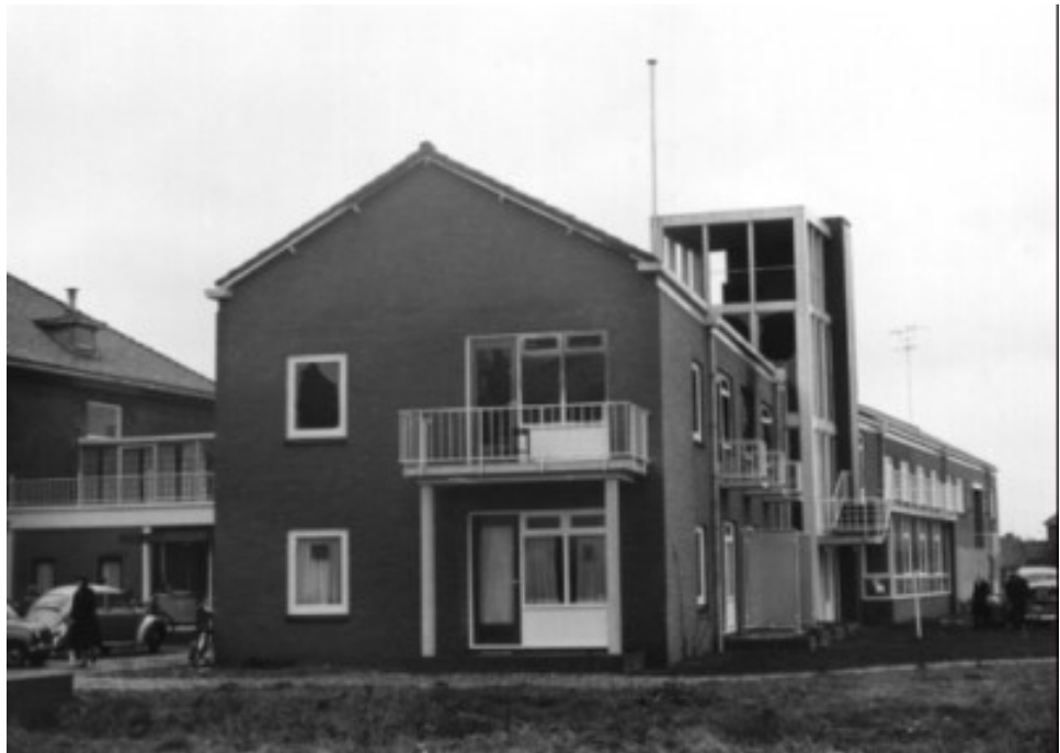
Het nieuwere gedeelte van het Zorgcentrum St. Jozef.
