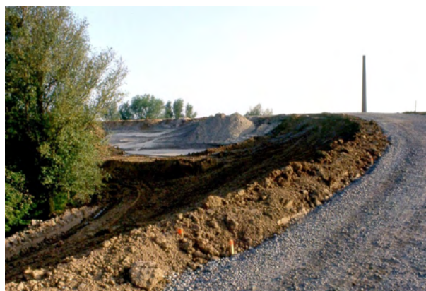
Dijkverzwaring, verhoging en verlegging 1989.
