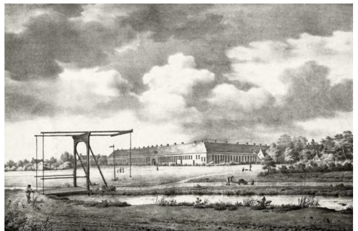
Zicht op het Derde Gesticht.
