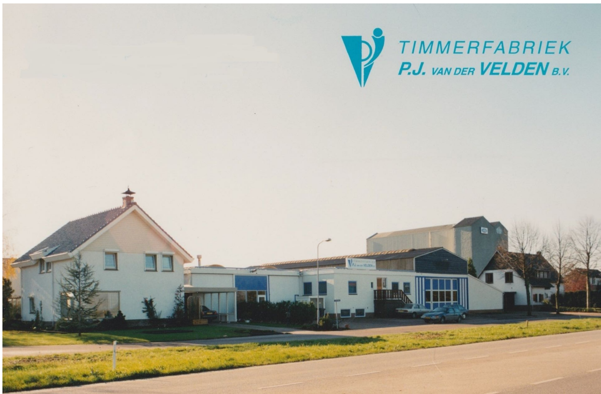
Het bedrijf aan de Langstraat.
