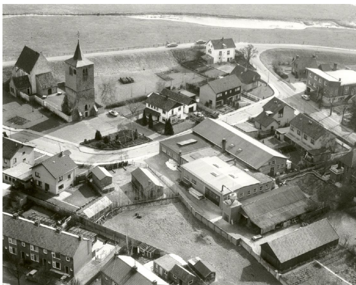
Luchtfoto van het bedrijf aan de Torenlaan.
