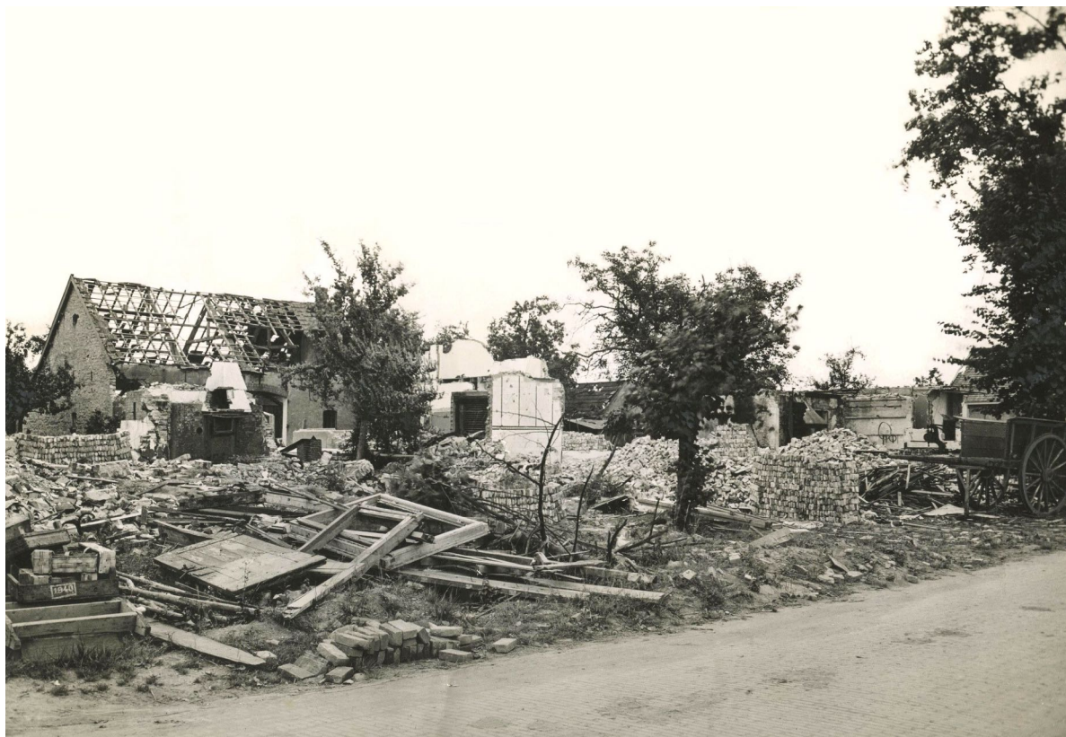
De door de luchtaanval in 1944 aangerichte verwoesting in de Dorpstraat. Links de schuur van slager Van Driel.
