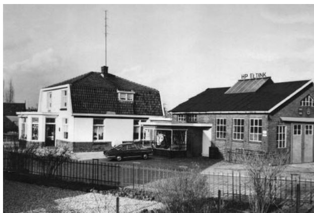
Het pand aan de Dijkstraat met smederij.
