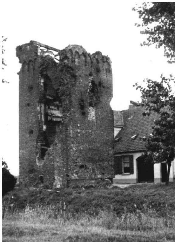
De zwaar beschadigde Poelwijktoren.
