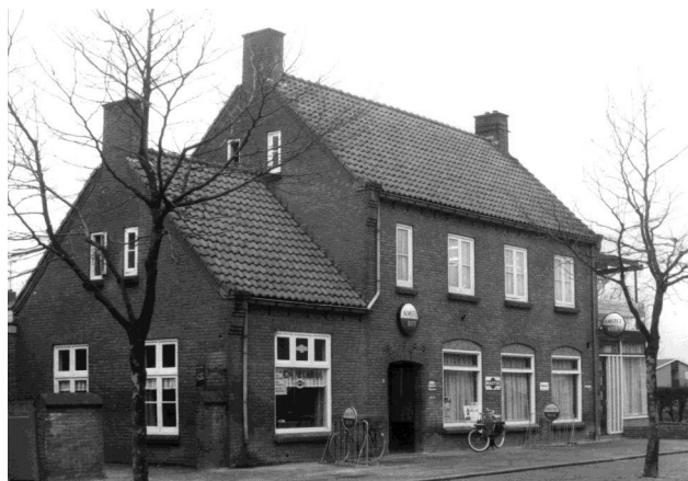
Het verbouwde pand met aan de achterkant een grote zaal.
