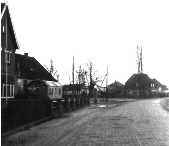
De Dorpsstraat net na de Tweede Wereldoorlog. Bij Van Leuven staat een bouwkeet die behoort bij de bouw van de R.K. noodkerk. Aan de straat is het pompstation.
