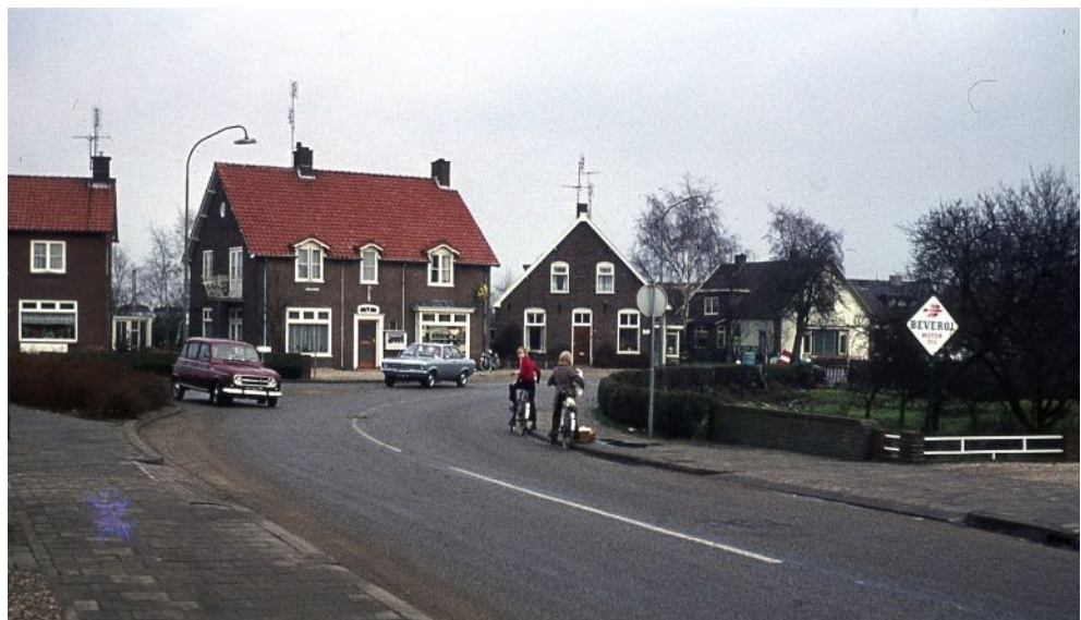
Eind Dorpstraat, begin Kapelstraat.
