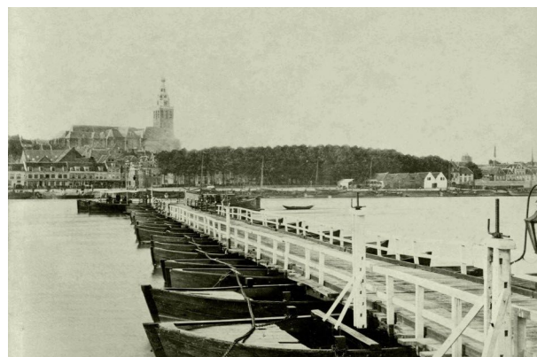
De schipbrug op de Lentse oever. De brug rust op een groot aantal pontons.
