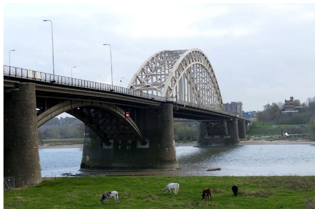
De Waalbrug die in 1936 het pontveer vervangen heeft. Het einde van een tijdperk.
