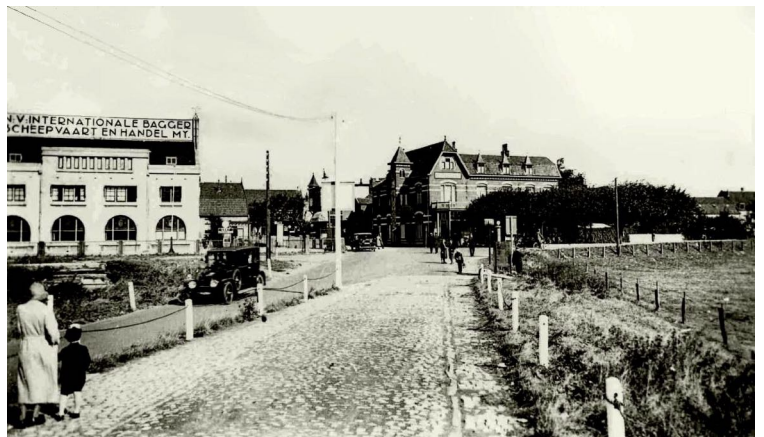
Links: het kantoor van de Baggermaatschappij Van Hasselt Lent. Midden: de op- en afrit naar de Schipbrug. Rechts: Hotel Lent.
