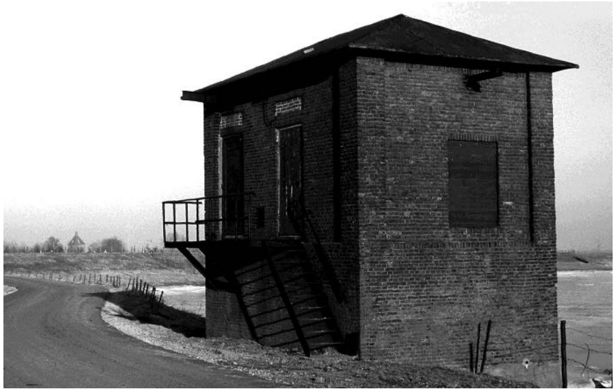
Het verdwenen pomphuisje aan de weg naar de Zandberg.
