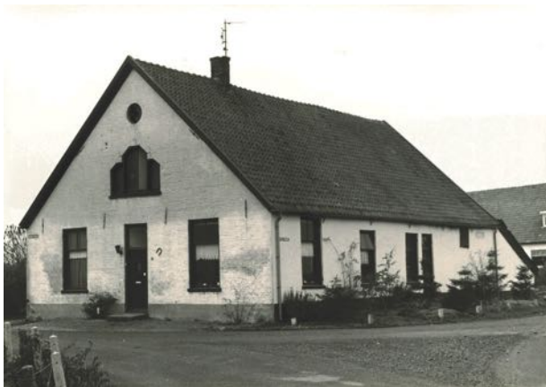
Vroeger was de ingang van de werkplaats bij de twee smalle ramen. Nu staat er een nieuw huis.
