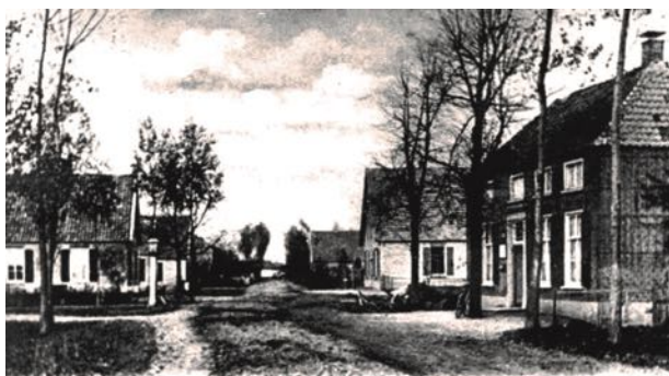
Geheel rechts het hulppostkantoor zoals het gebouwd is in 1851.
