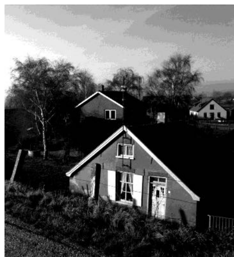
Het met de dijkverzwaring gesloopte 'zilveren huisje'.
