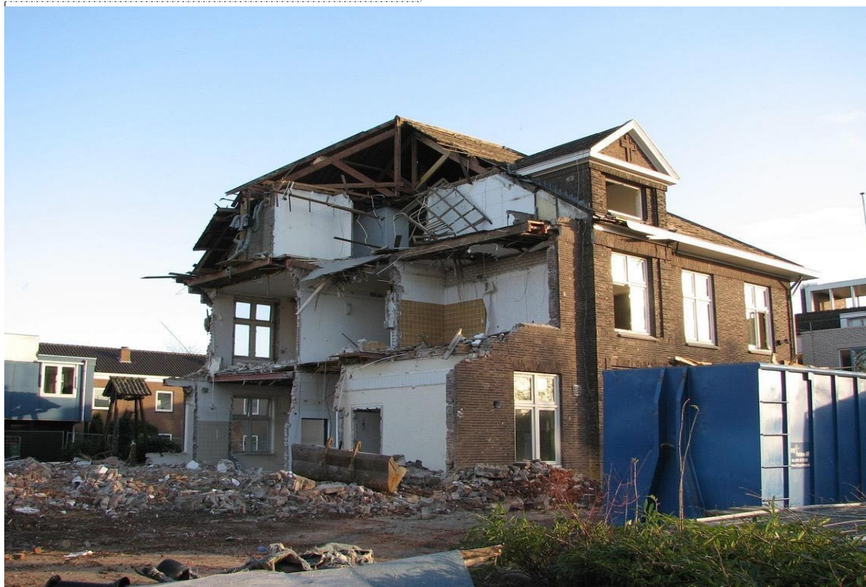
Gedeeltelijke sloop van het Zorgcentrum St. Jozef
