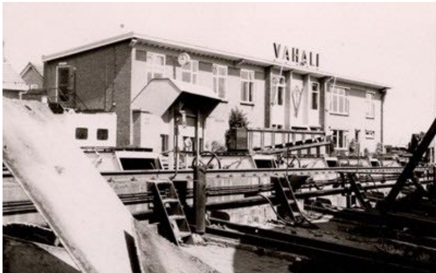
Links in het gebouw de kleed- en wasruimte met erboven de kantine en rechts het kantoorgedeelte.
