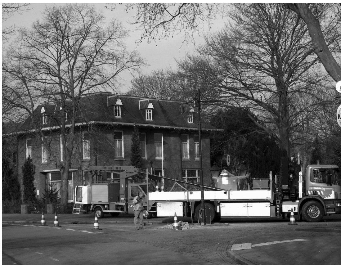
De klok op het kruispunt Nijmeegsestraat/Dorpstraat is onlangs heel wat hoger komen te hangen. Hier zijn de voorbereidingen in volle gang
