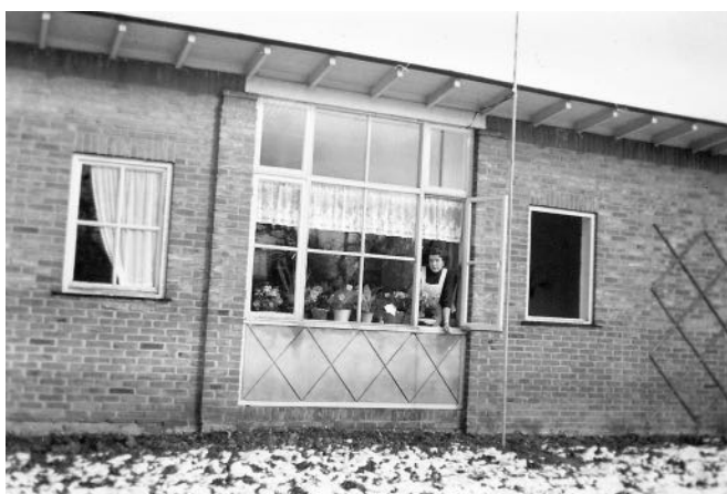
Noodwoning aan de Raalt (1945-1967)
