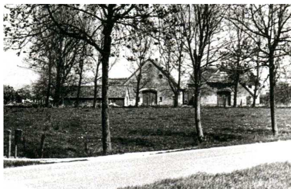
De achterzijde van de Lootakkers vanaf de Langstraat gezien vóór 1968
