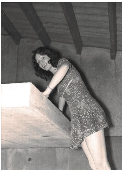
Yvonne de Boer neemt tijdens de bouw een kijkje op de entresol. Duide-lijk is het golfplaten dak te zien. Aan de binnenkant werd het dak later alleen afgewerkt met steenwoldekens en schrootjes.
