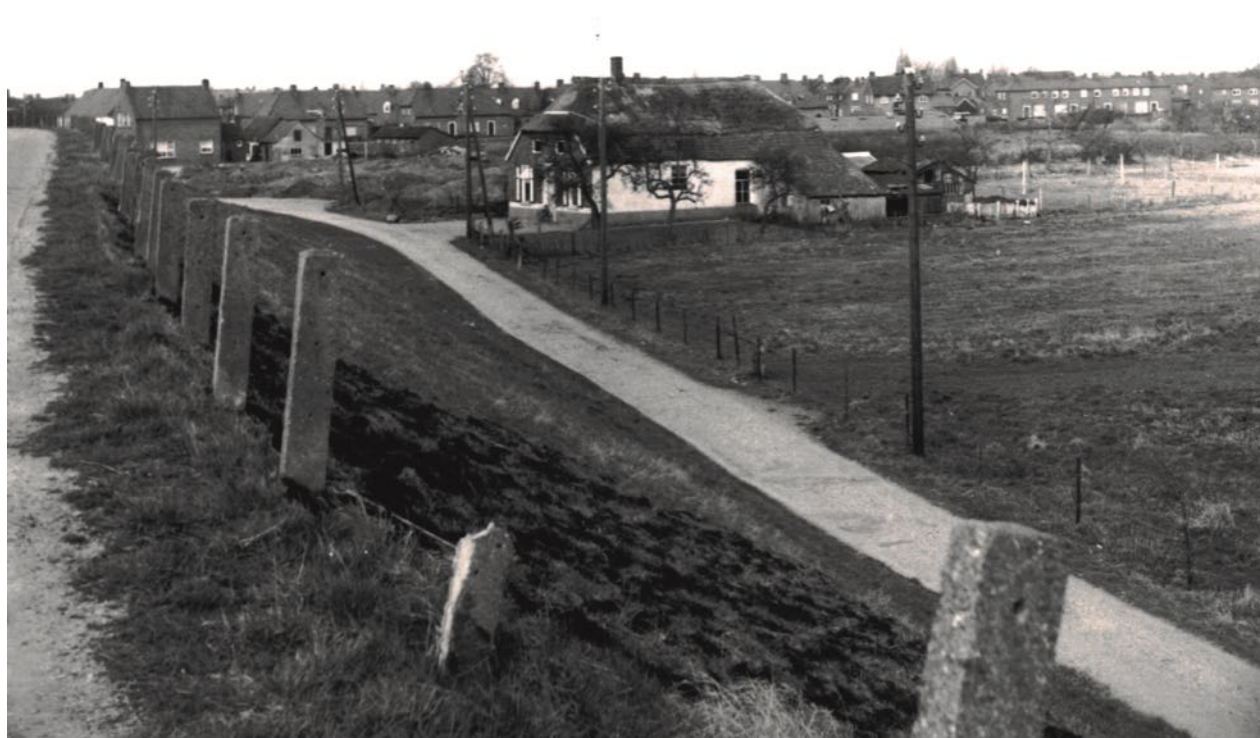
De weg onder de dijk heette in de volksmond Onderlangs en officieel Dijkstraat. Op dit moment (rond 1970) zijn al enige huizen gesloopt voor de bouw van de wijk Dries.
