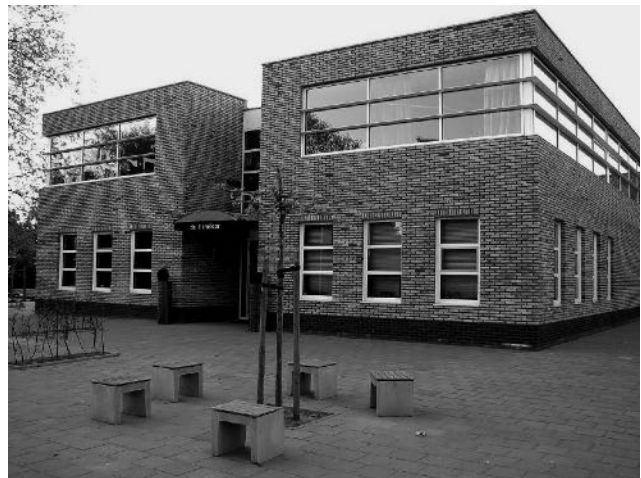
Het nieuwe Tichelaargebouw aan de Nijmeegsestraat
