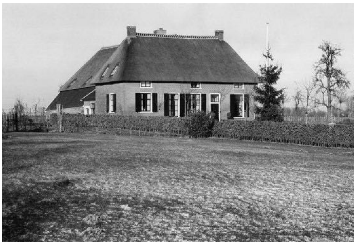
Boerderij de Loohof na de restauratie in 1999
