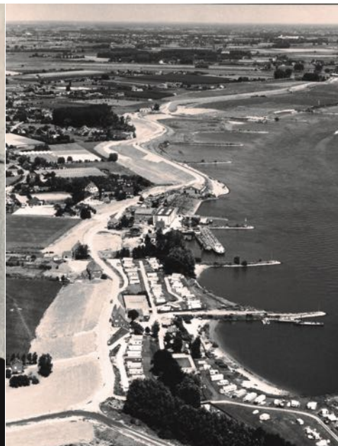
Hulhuizen tijdens de dijkverzwaring
