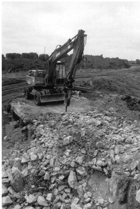
Het fijn trillen van de beton
